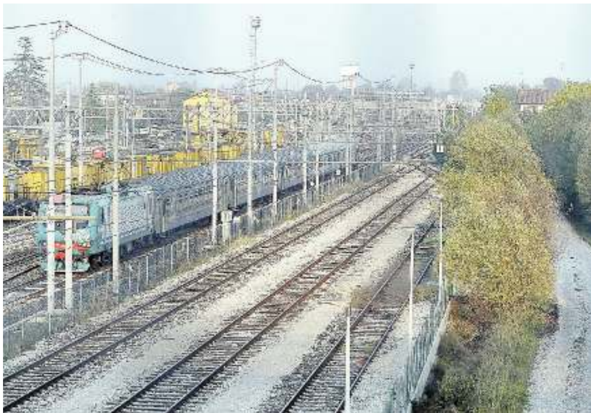
CANTIERI Lungo via Volpare saranno installate le barriere fonoassorbenti
