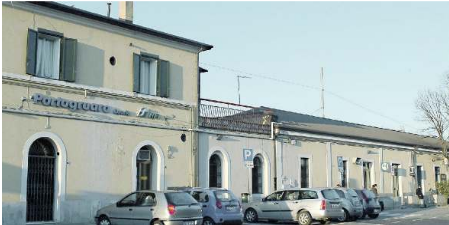
DUE RICHIESTE La zona della stazione, nella quale dovrebbe essere collocata una delle antenne con la nuova tecnologia
