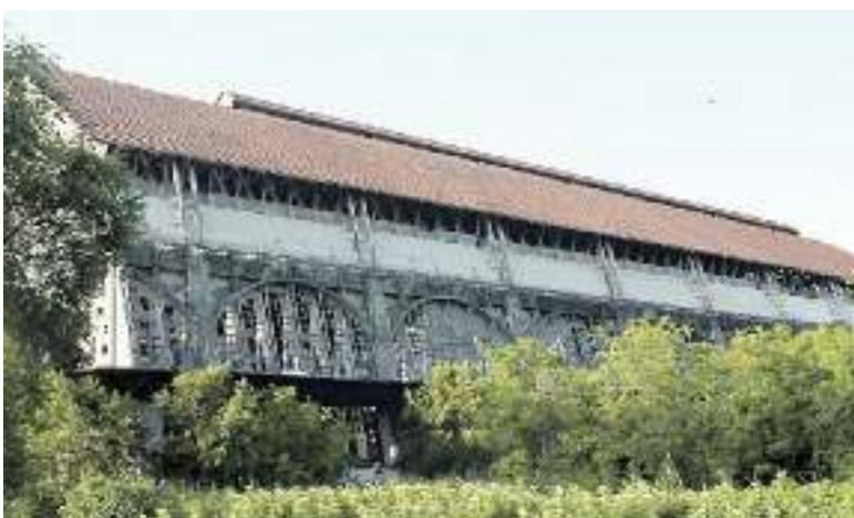
EX PERFOSFATI Domani cerimonia per l'avvio dei lavori
