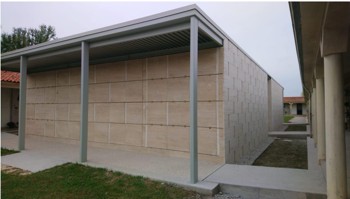
Loculi di nuova realizzazione
